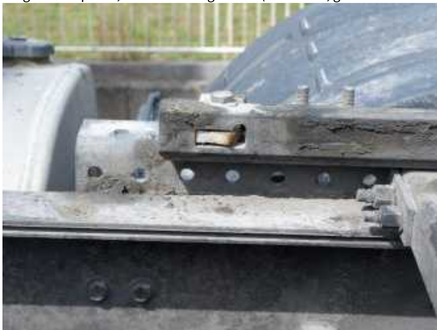
Träger Sattelplatte, Befestigung / Arretierung abgerissen (Archivbild, gleicher Schadenhergang)
